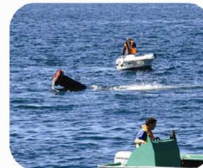
(13) Une fois descendu le tronçon, le plongeur descend pour récupérer **les flotteurs et fermer l'entrée/sortie d'air/eau**. Le tronçon terminé reste effondré jusqu'au jour suivant, pour répéter tout le processus.
