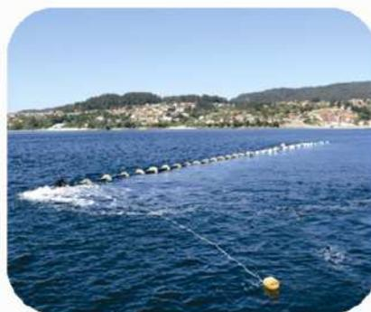
(12) Le **remplissage de la tuyauterie avec eau potable** fait que celle-ci s'effondre jusqu'à l'extrémité finale avec la bride, où à son tour est expulsé l'air de l'intérieur. L'objectif est que l'effondrement soit fait avec un rayon de courbure le plus vaste possible, pour éviter ainsi que les unions souffrent dans le processus.
