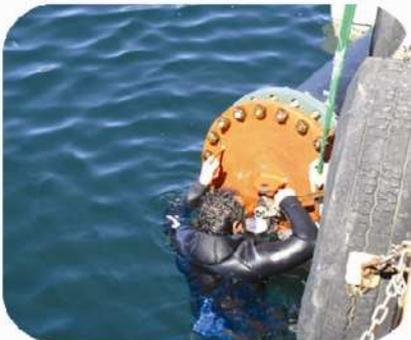
(10) Mise en place dans l'extrémité de la tuyauterie non unie, avec aide d'un plongeur, d'un **manomètre** et d'une **valve**. D'abord on introduit de l'air sous pression jusqu'à équilibrer avec la pression de l'eau.
