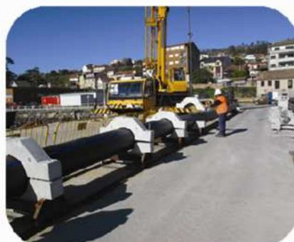
(5) Mise en place chaque 2.5 m des **mortiers de béton** (recouverts de néoprène pour que la tuyauterie ne souffre pas) sur les rails d'accès à la mer.
