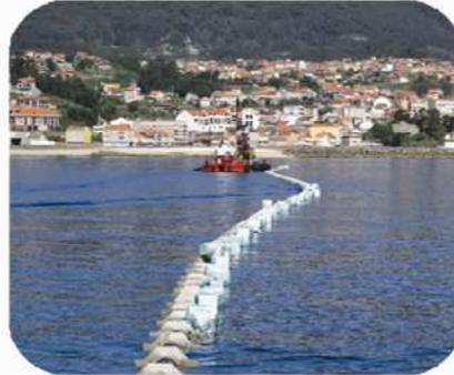
(9) **Union des deux tronçons** de tuyauterie avec brides placées à chaque extrémité et mise en place de **flotteurs** pour faciliter la manœuvre d'effondrement.
