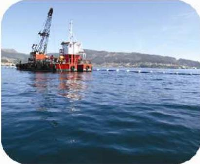
(8) **Remis à flot** du tube effondré le jour précédent et mise en place sur la plate-forme avec aide de la grue. Mise en place sur la même plate-forme du tronçon de 325 m apporté de la plage de Moaña.
