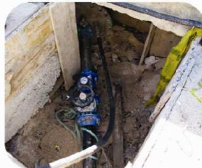
(11) Depuis terre on contrôle l'injection d'eau potable (**ouverture de clés**). Équilibrées les pressions aux deux extrémités, on injecte de l'eau potable à la tuyauterie qui pousse l'air qui sort sous pression par la valve.
