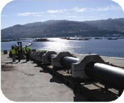
(6) **Lancement** à la mer de tronçons de 65 m qu'on unit par soudure, jusqu'à former des **longueurs de 325 m**.
